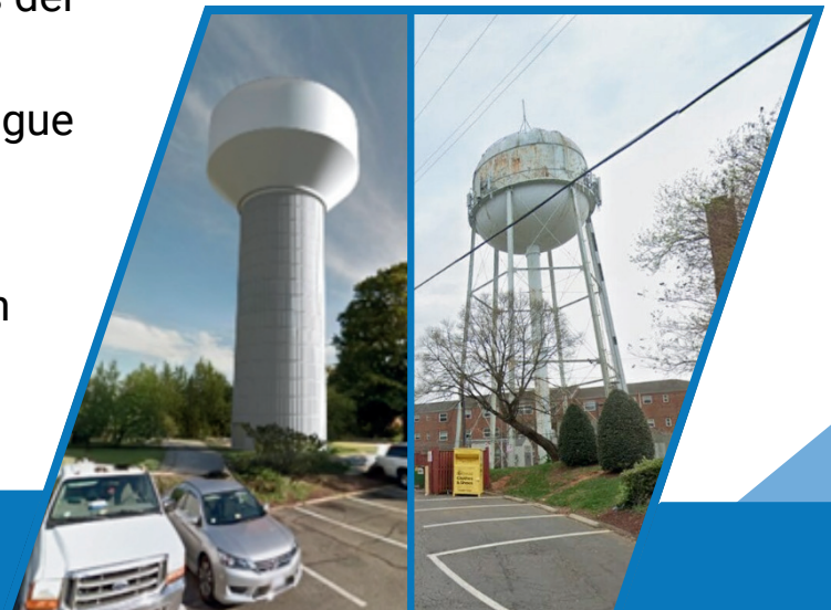
Tanque propuesto y tanque actual.
